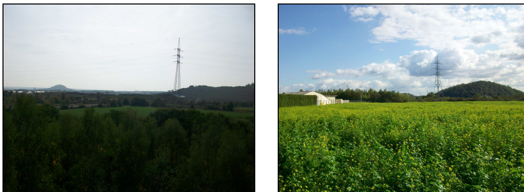
Figure 19: Exemples de vues des pylônes sur Charleroi
